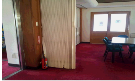
⑦1階消火器の設置
